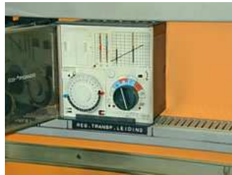
Régulateur analogique avec visualisation directe de la courbe de chauffe.
