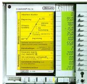
Boîtier de dialogue pour régler la courbe de chauffe sur un régulateur électronique.
