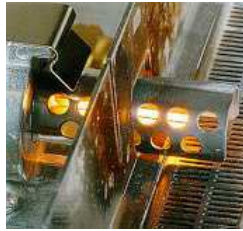
Electrode incandescente d'allumage d'un brûleur atmosphérique.
