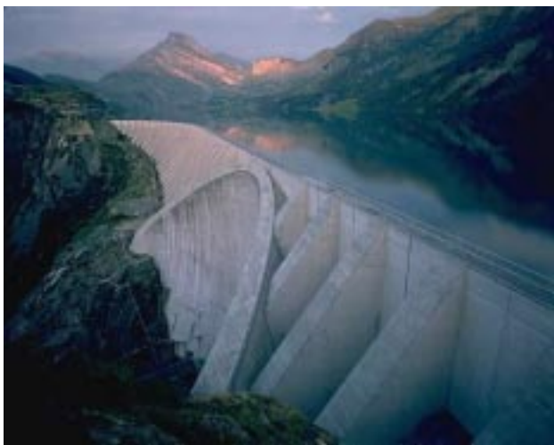
Barrage et Retenue de Roselend, en Savoie, au soleil couchant, vue d'aval La médiathèque EDF/Pierre Bérenger
