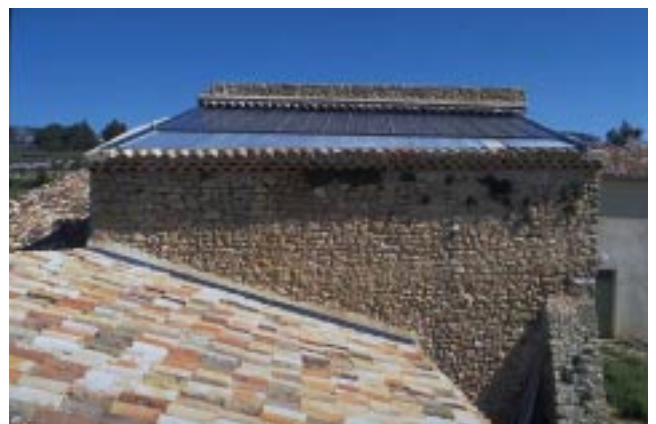
Panneaux photovoltaïques sur le toit de la ferme de Majorques (Lubéron) : panneaux vus de dessous.
