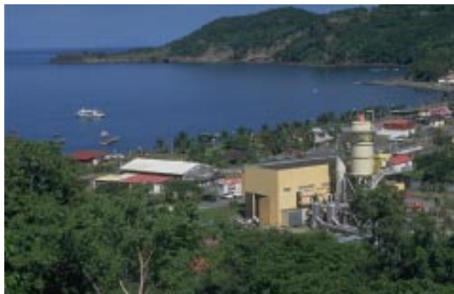
Centrale Géothermique de Bouillante, en Guadeloupe La médiathèque EDF/Marc Monceau
