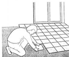
6 Pose du revêtement de sol après séchage et première mise en température progressive.
