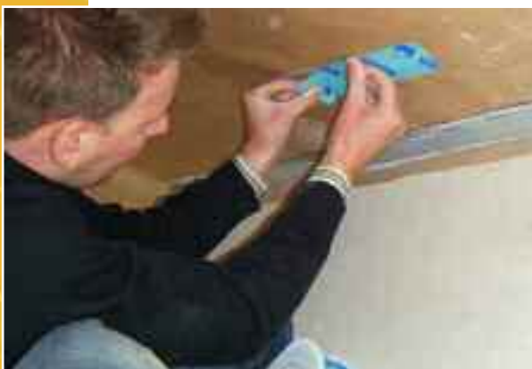
Réparation d'un percement du freine-vapeur à l'aide d'une bande adhésive spécifique
