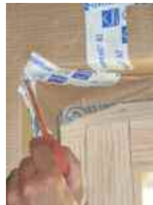
Test intermédiaire et détection des défauts par la poire à fumée
