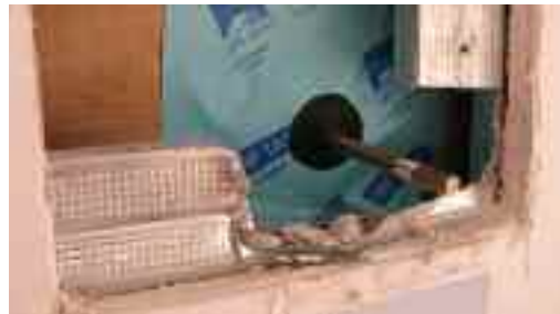
Solution retenue : utilisation d'une manchette souple adaptée
