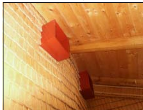
Canal à air chaud pour dernier niveau
