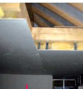
Isolation des combles.
