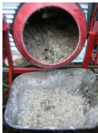
2 – Mélange prêt à être utilisé lorsque commencent à se former des boules
