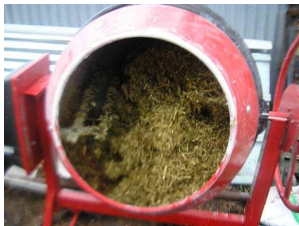
1 – Humidification de l'enduit
