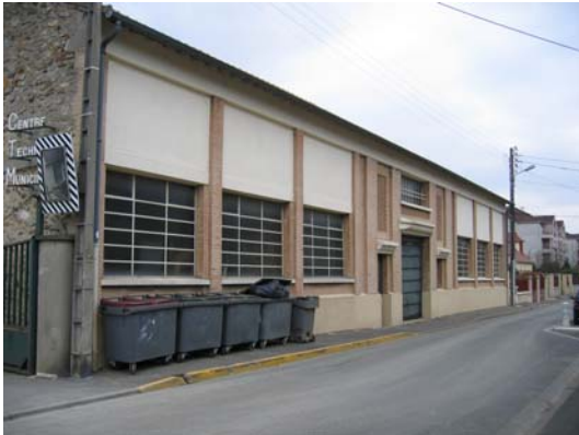
Bâtiment existant : vue de la façade sur rue. cour.
