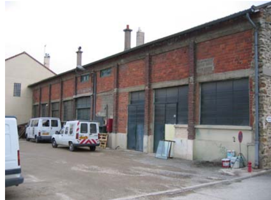
Bâtiment existant : vue de la façade sur cour.
