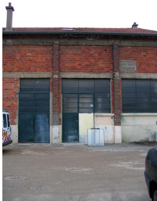
Bâtiment existant : travée type, façade sur cour.
