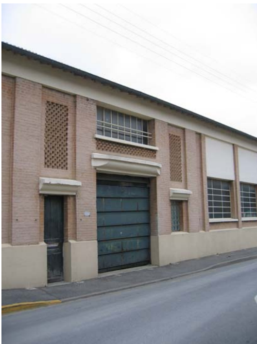
Bâtiment existant : vue du porche principal.
