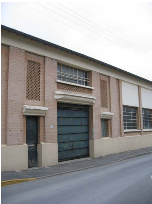
Bâtiment existant : vue du porche principal.
