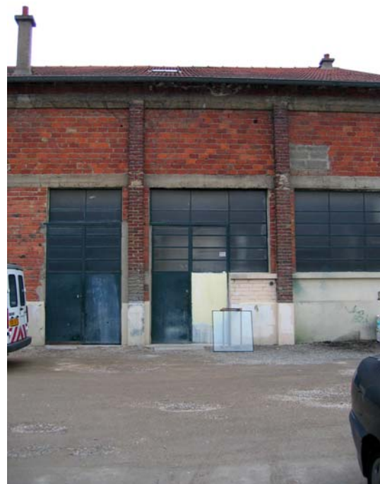
Bâtiment existant : travée type, façade sur cour.
