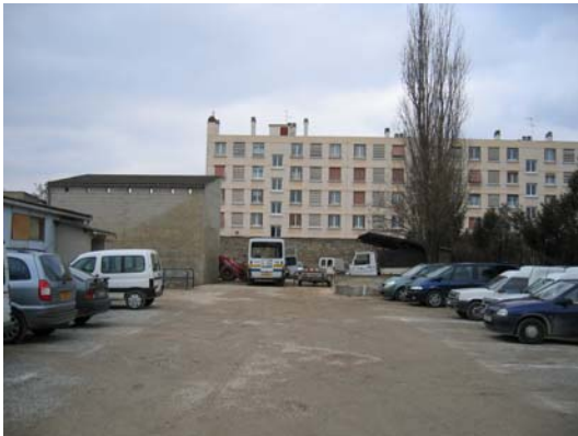
3. Vue partielle du site vers l'est.
