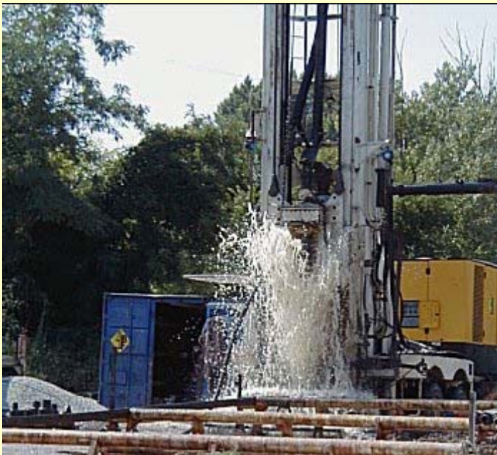
Atelier de forage (développement du forage)
